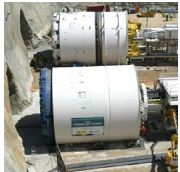
Larawan 2. Larawan ng mga makina sa paglikha ng tunel na gagawa ng dual-bore na tunel.
